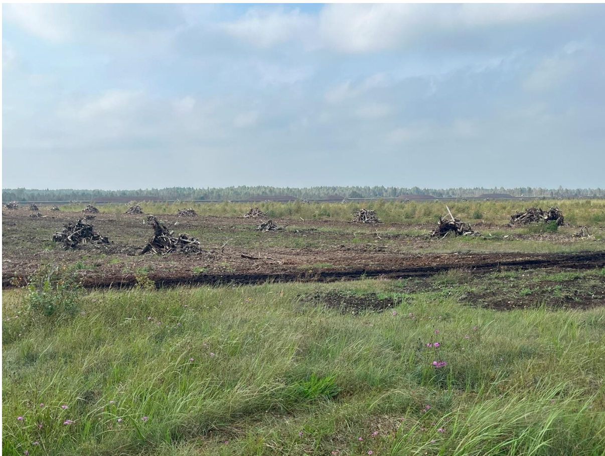
Foto 4.8. Piilasoo turbatootmisala P-X väljak, kust eemaldatakse olemasolev taimkate (kasevõsa) ja mis võetakse uuesti turbatootmiseks kasutusse (OÜ Inseneribüroo STEIGER, 12.09.2023).
